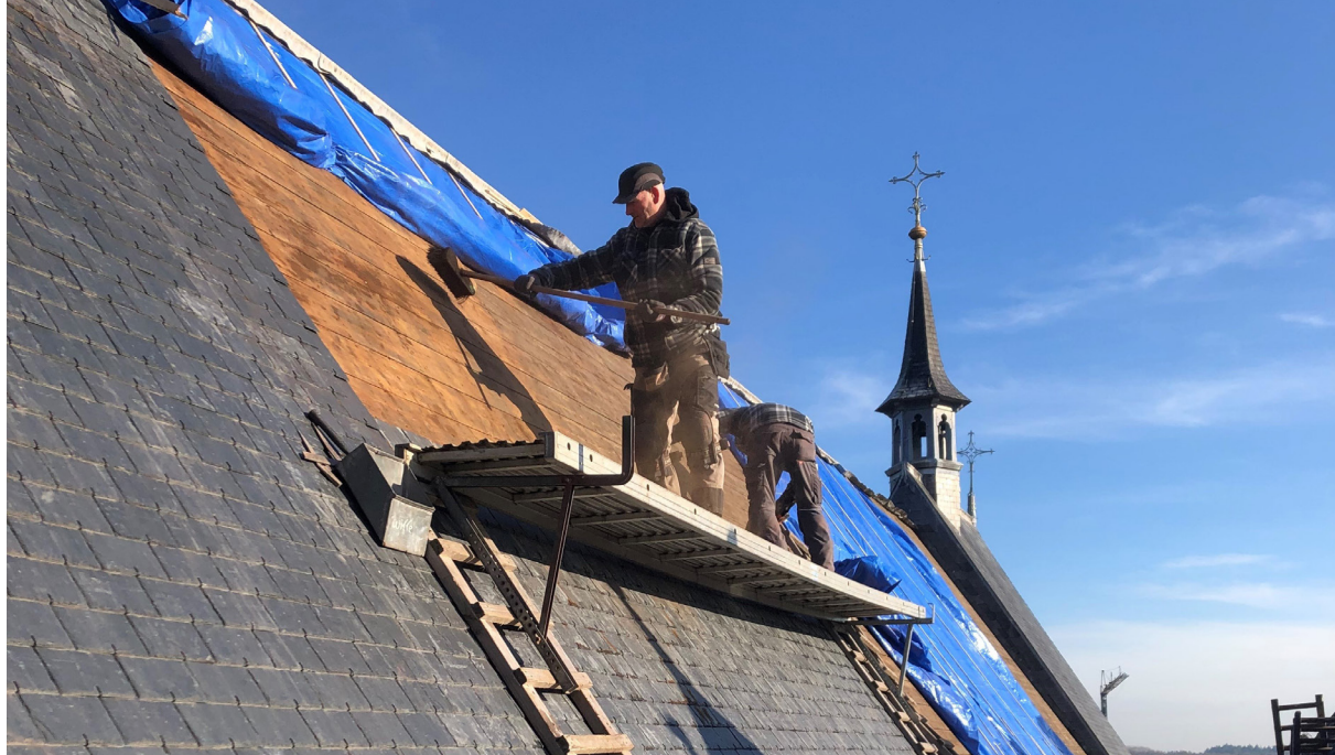
Herstel van het dak van de kerk in Heythuysen
