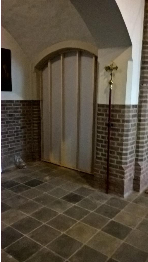
Zo, de wand is geplaatst, nu nog afwerken
